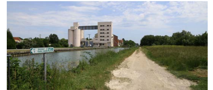
Canal latéral à la Marne, à hauteur de Condé-sur-Marne
