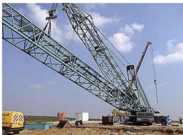
Illustration 65 : Grue de levage sur une plateforme
