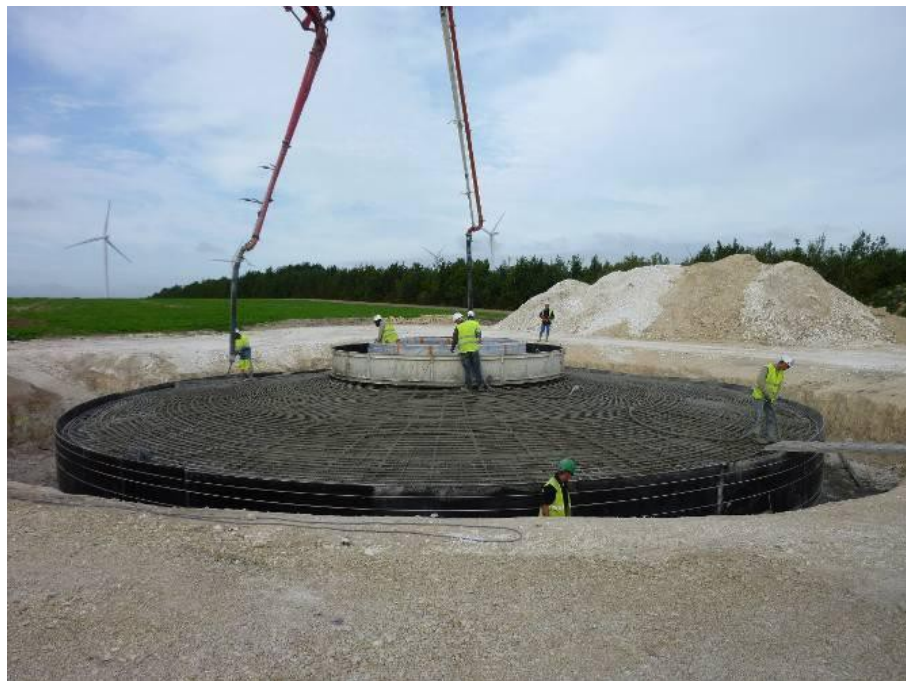
Illustration 64 : Construction d'une fondation
